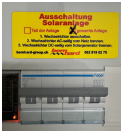
Der 4-polige LS-Automat wird verwendet, wenn der Wechselrichter im selben Raum und im Blickfeld installiert ist. In diesem Fall kann auf einen zusätzlichen AC-Anlageschalter beim Wechselrichter verzichtet werden.
